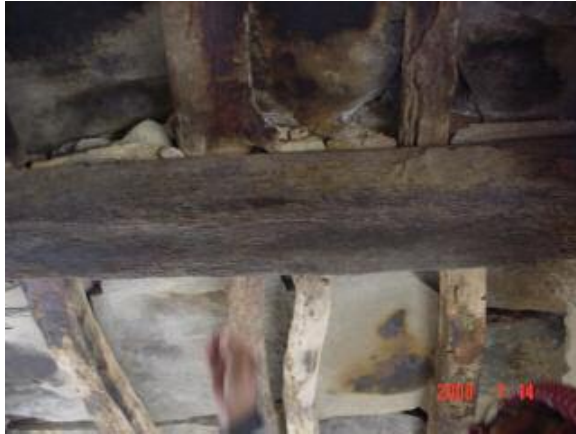
شكل 10: صورة توضح مكونات السقوف في المباني التقليدية
