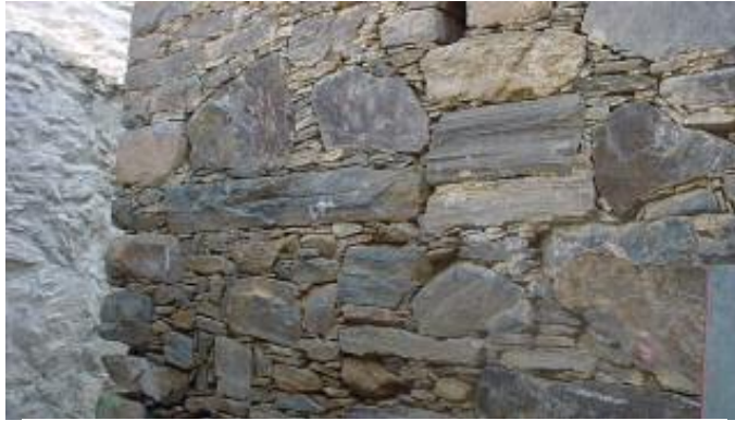
شكل 5: يوضح بناء الجدار وطريقة وضع المياضير تحت أو في جوانب الحجر للحصول على التوازن والترابط المطلوب للحجارة
