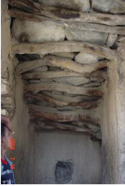
شكل 11: صورة توضح مكونات سقف الدرج
